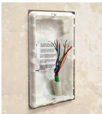
Remplacement de la platine de rue
