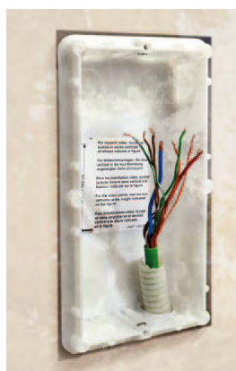
Remplacement de la platine de rue
